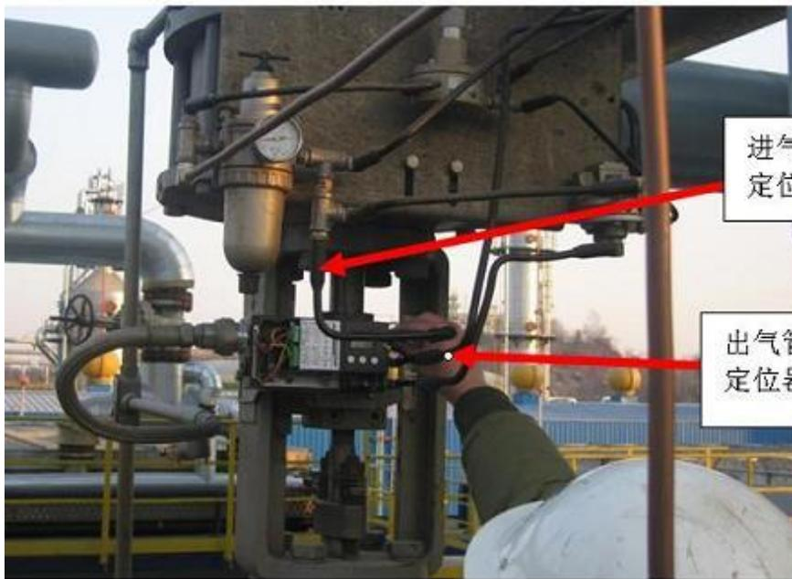
进气管路, 接到了阀门定位器的出口位置
